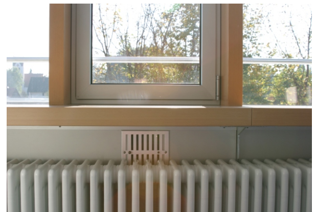
Innenansicht - Alu-Schiebeverschluss GALD
