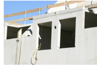
Vorgefertigte Systembauteile enthalten bereits die Öffnungen für die Lüftung
