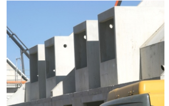
Vorgefertigte Systembauteile enthalten bereits die Öffnungen für die Lüftung
